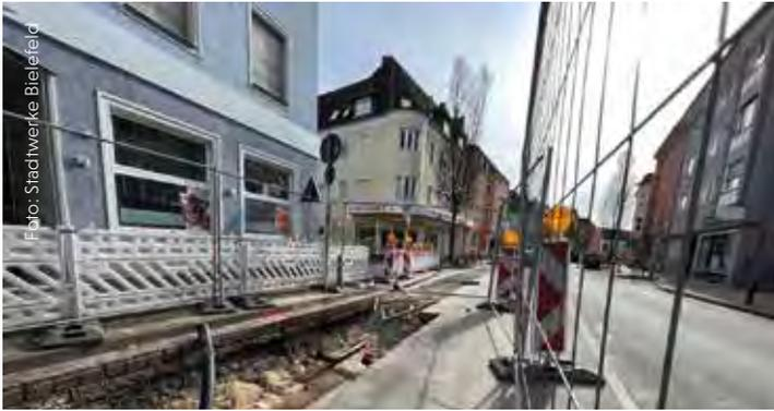
Leerrohre für das neue 110-kV-Kabel
