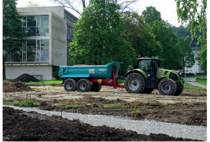
Umbauarbeiten in vollem Gange (Foto: Karl-Gustav Heidemann)
