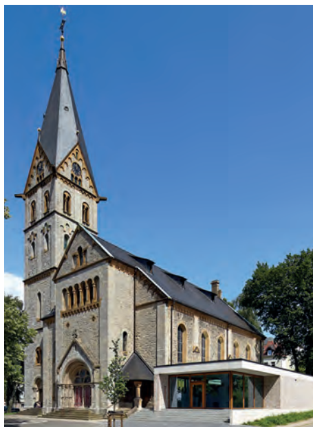
Erweiterungsbau der Johanniskirche (Foto: brewittarchitektur)
