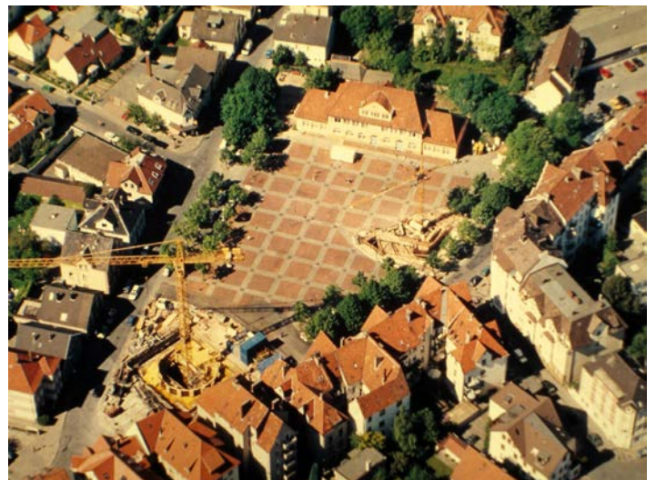
Oberirdische Baustellen für die beiden Zugänge zur Stadtbahnhaltestelle (Foto: Amt f. Verkehr)
