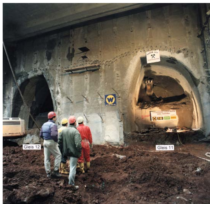
Tunneldurchschlag (Foto: Amt für Verkehr)
